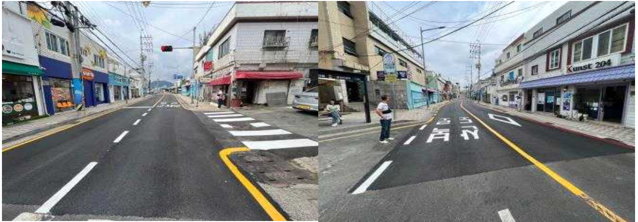
▲ 현여울문화마을 침수해소사업 (완료)
